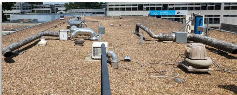
Dépose des équipements supprimés - Dépose - Repose des équipements conservés (tourelle sorbonne, ....)
